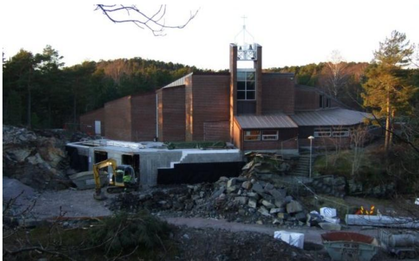
Bygging av nytt servicebygg, Voie kirke. Foto: Harry Omdal
